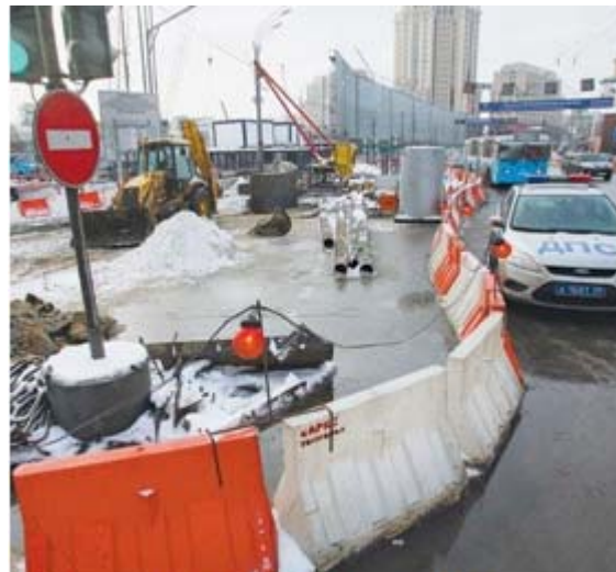
Когда стройка у Павелецкого вокзала завершится, заторы на Садовом кольце станут еще более непробиваемыми (фото: Владимир Суворов, "Известия")
