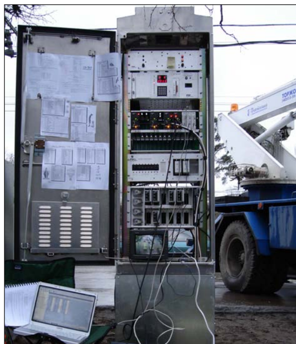
Установка адаптивного контроллера на Волоколамском шоссе
